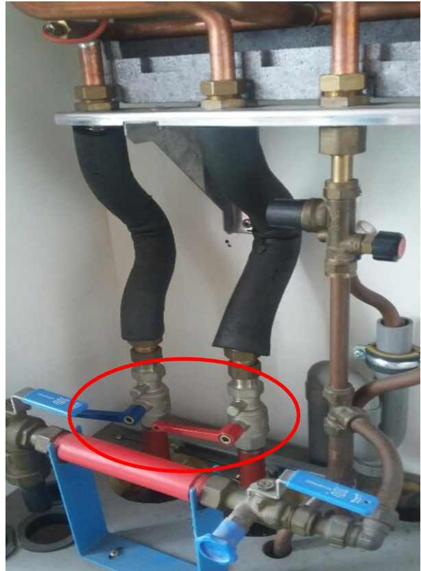
Laagbouw, afsluiter (haaks) = DICHT
